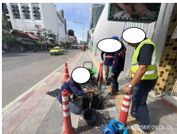
รูปที่ 2-42 เจ้าหน้าที่ตรวจสอบและขุดลอกตะกอนบริเวณท่อระบายน้ำด้านหน้าโครงการ
