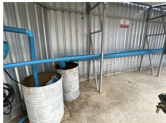
รูปที่ 2-11 บ่อพักน้ำ/บ่อดักตะกอนดิน และ LAYOUT SITE DRAINAGE ภายในโครงการ
