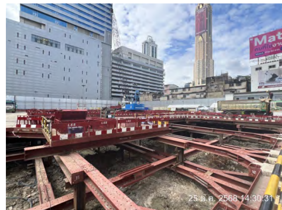
รูปที่ 2-8 ระบบค้ำยัน (Bracing)
