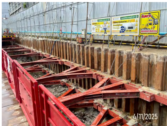
รูปที่ 2-7 ระบบป้องกันดินพัง (Sheet pile)
