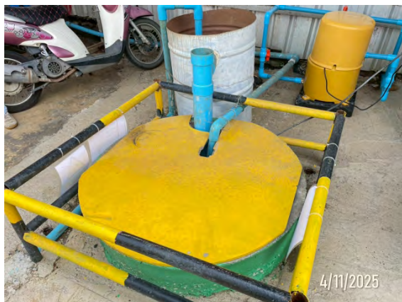
รูปที่ 2-11 บ่อพักน้ำ/บ่อดักตะกอนดิน และ LAYOUT SITE DRAINAGE ภายในโครงการ
