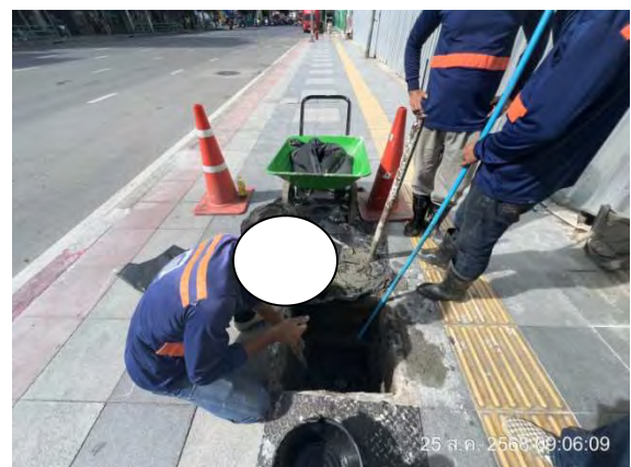
รูปที่ 2-42 เจ้าหน้าที่ตรวจสอบและขุดลอกตะกอนบริเวณท่อระบายน้ำด้านหน้าโครงการ
